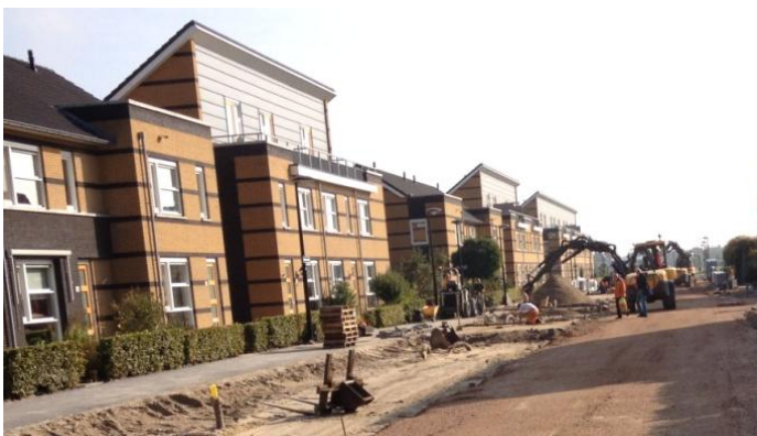
Figuur 30: Trottoir is voor de verharding aangelegd
