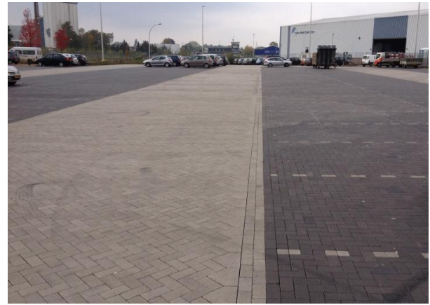
Figuur 3: Vlak terrein met waterdoorlatende verharding
