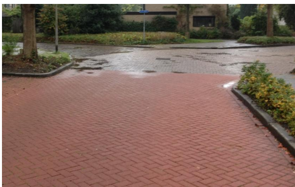
Figuur 2: Overgang infiltrerende naar conventionele verharding
